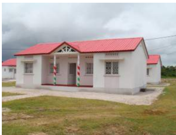
Toamasina : 28 logements type F4
